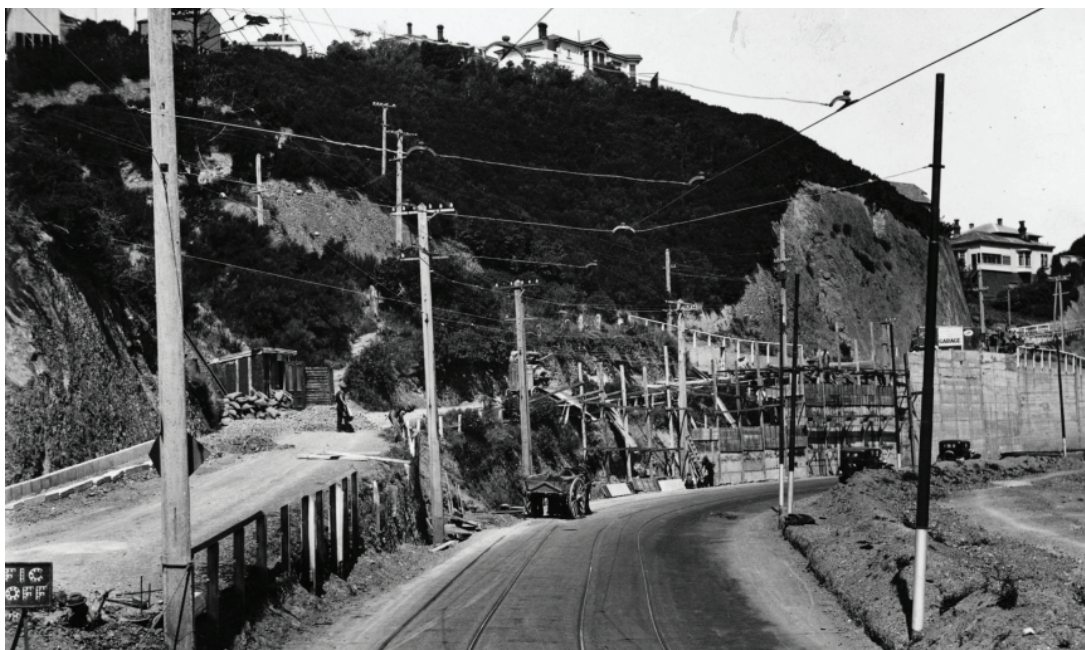
Figura 1: Questa foto degli anni '20 mostra l'ardua sfida della costruzione del muro di sostegno originale.
